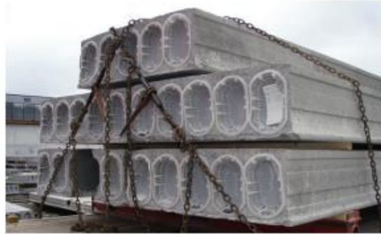
Ontelolaattakuorman ristiinsidonta edessä.
